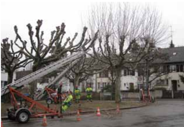
Installation der mechanischen Leiter
