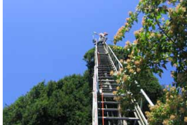
Arbeiten auf der mechanischen Leiter
